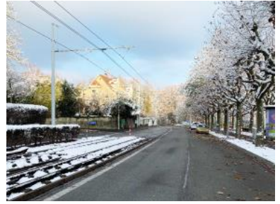
Neue Haltestelle beidseitig Eichhornstrasse
